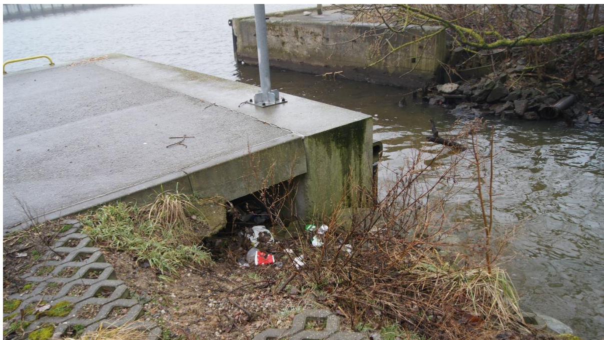
Fotografia powyżej : Widok na uszkodzone zakończenie Nabrzeża Parkowego na styku z ciekim wodnym wpływającym od wschodu do Kanału (rzeka Wieprza)
