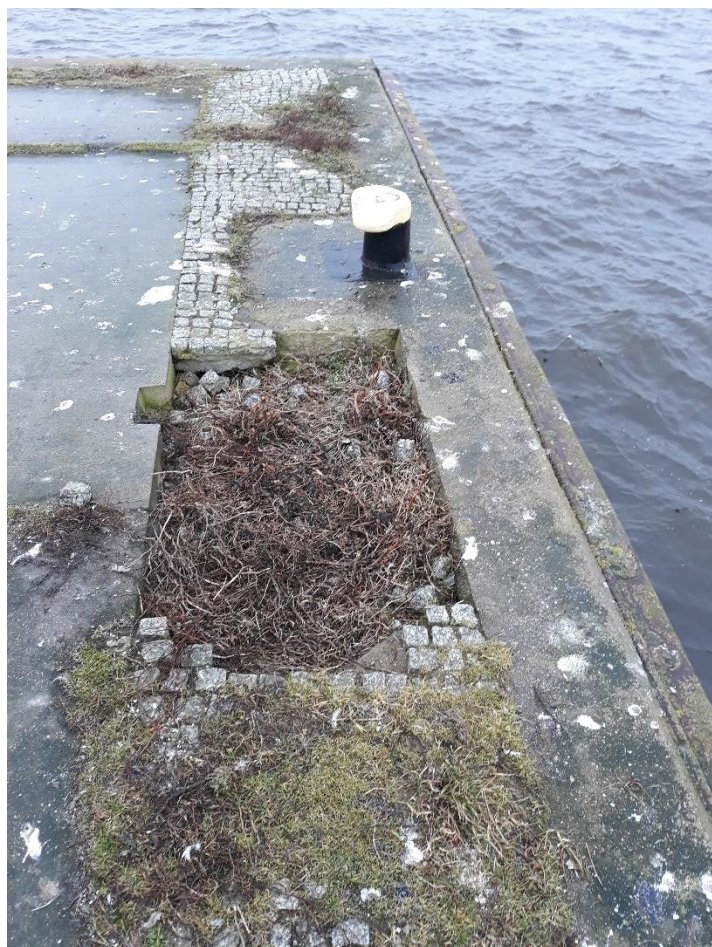
Fotografia powyżej i poniżej : Widok na miejscowy brak nawierzchni Nabrzeża Postojowego do uzupełnienia wraz z podbudową (część II)
