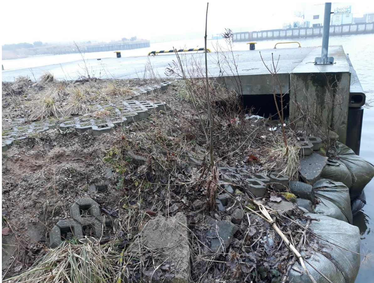
Fotografia powyżej : Widok na uszkodzoną skarpe i wraz ze zniszczoną okładziną z płyt ażurowych Meba wraz z wnęką – „jamą” – wynik wypłukania podbudowy nawierzchni końcówki Nabrzeża Parkowego (część 1)
