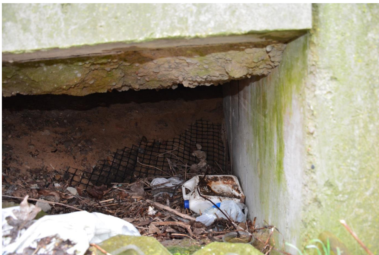
Fotografia powyżej : Widok na uszkodzone zakończenie Nabrzeża Parkowego na styku z ciekim wodnym wpływającym od wschodu do Kanału (rzeka Wieprza)
