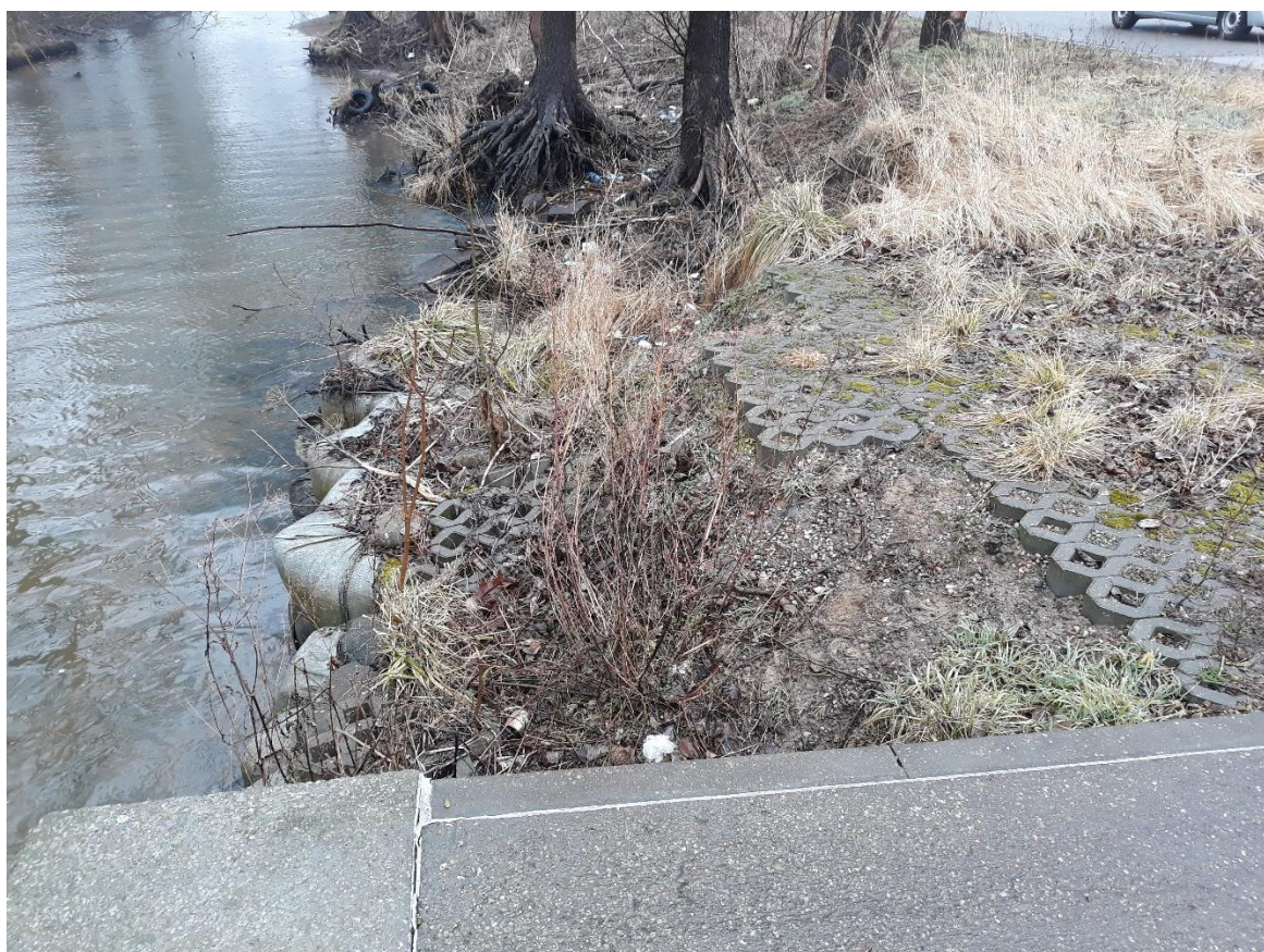
Fotografia powyżej i poniżej : Widok na oczepek żelbetowy na przedłużeniu którego należy zabić palisadę zakończoną „skrzydełkiem” (część 1)
