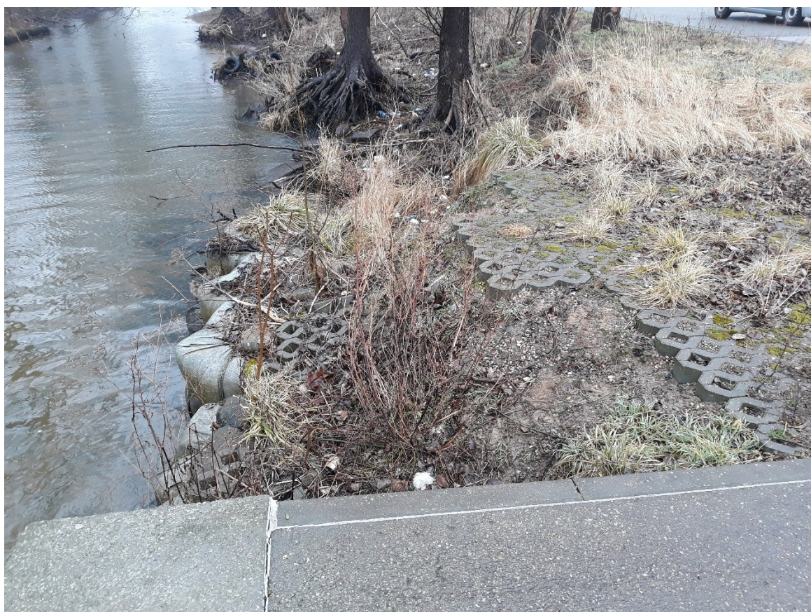
Fotografia powyżej i poniżej : Widok na oczepek żelbetowy na przedłużeniu którego należy od nowa ułożyć umocnienie z geokontenerów (część 1)
