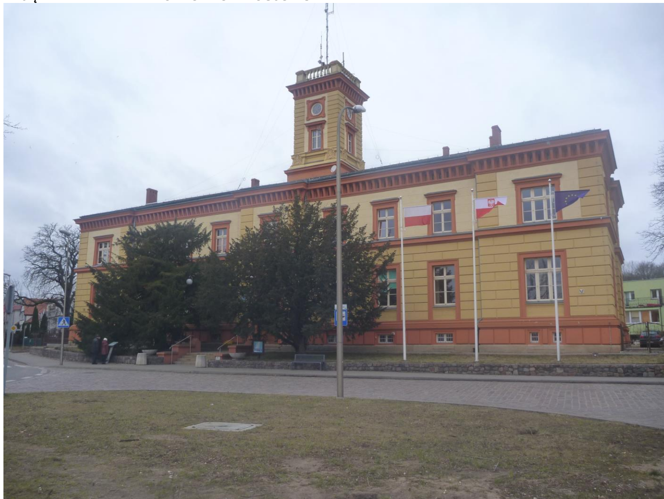
Fot. 01 Widok ogólny – elewacja frontowa
