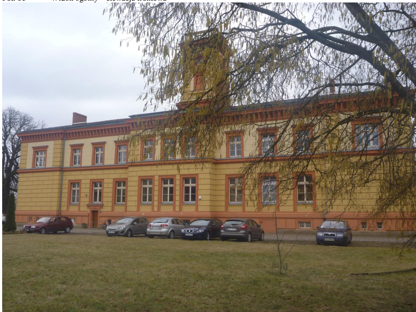
Fot. 02 Widok ogólny – elewacja tylna
