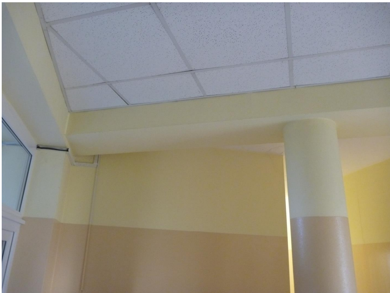
Fot. 23 Budynek byłego MPG. Korytarz główny
