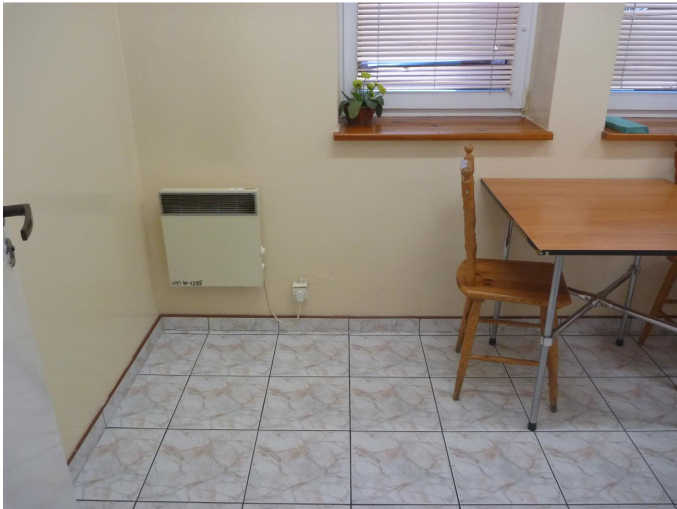
Fot. 42 Budynek byłego MPG. Zaplecze służbowe
