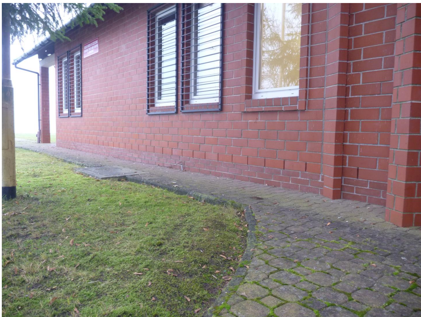
Fot. 09 Elewacja zachodnia
