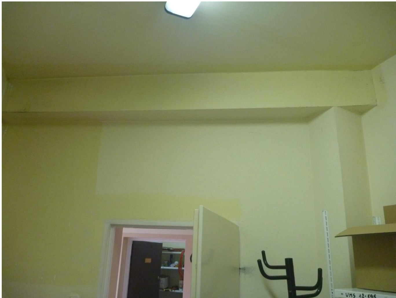
Fot. 40 Budynek byłego MPG. Widoczny fragment ustroju nośnego wyższej części obiektu
