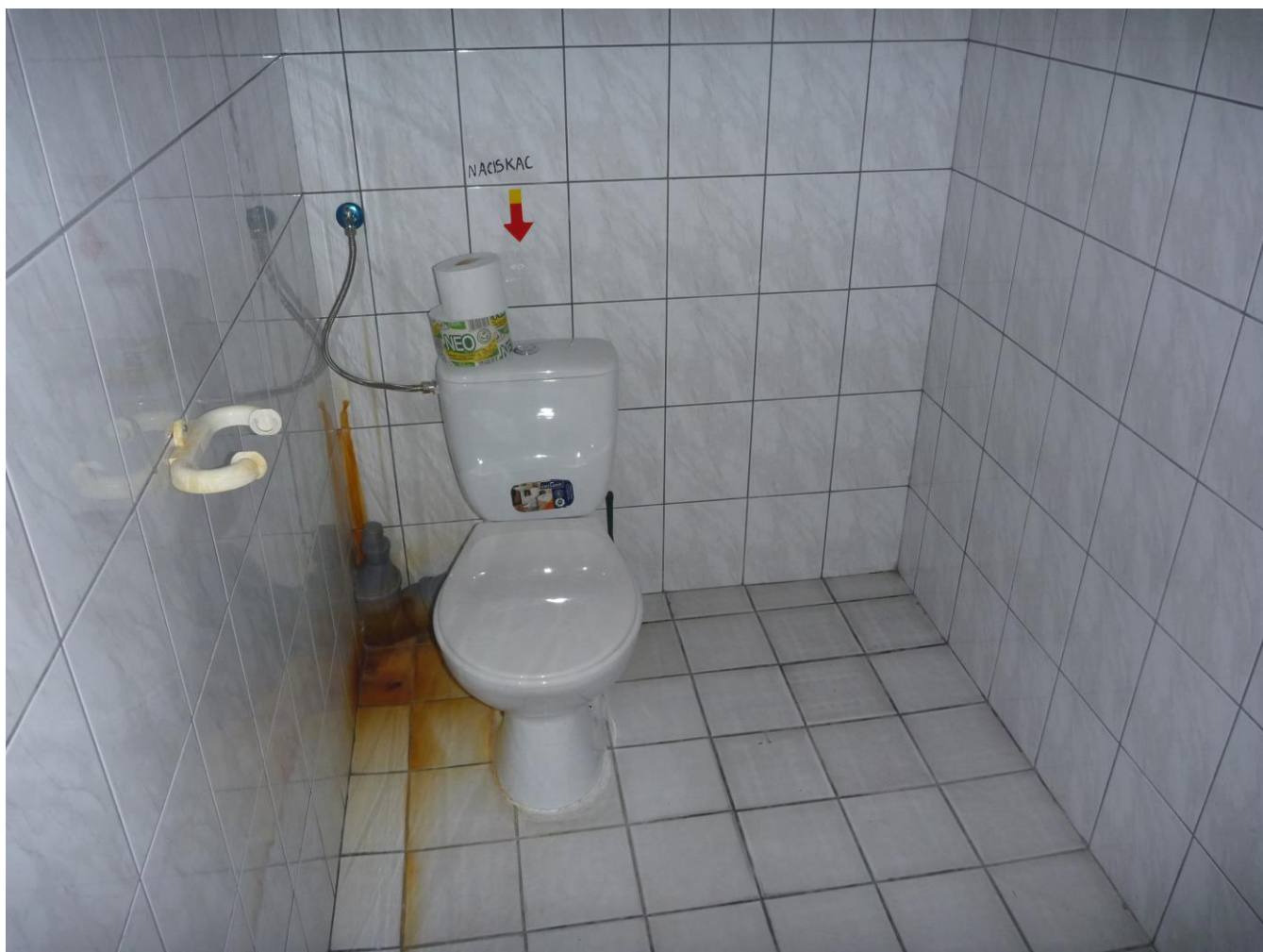
Fot. 47 Budynek byłego MPG. WC
