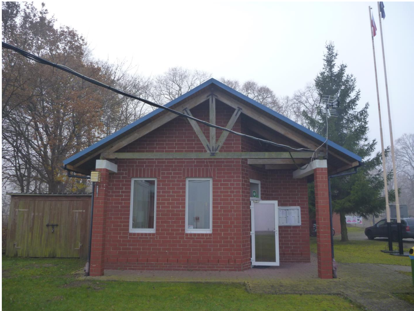
Fot. 06 Widok od strony północnej
