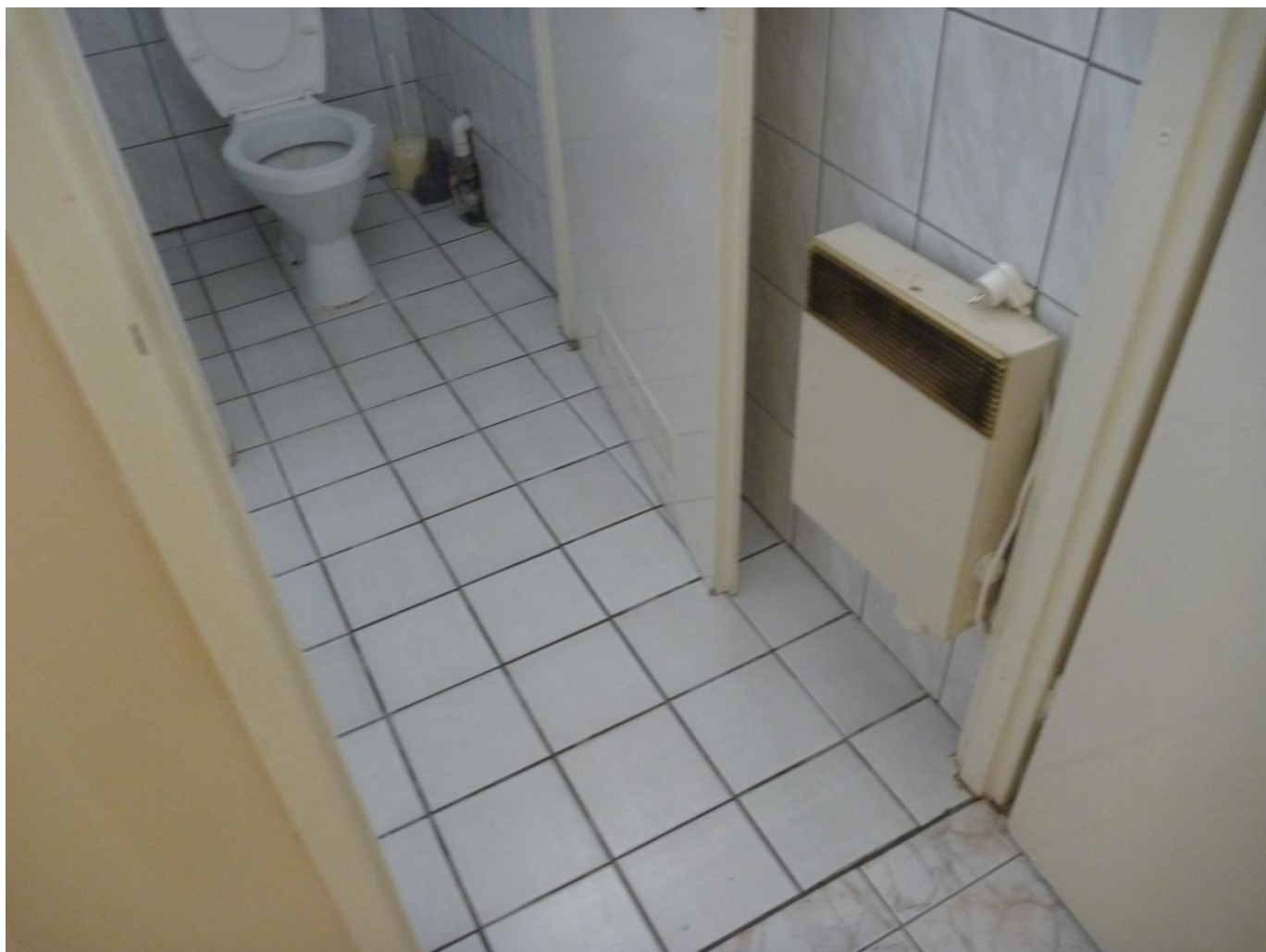
Fot. 45 Budynek byłego MPG.WC
