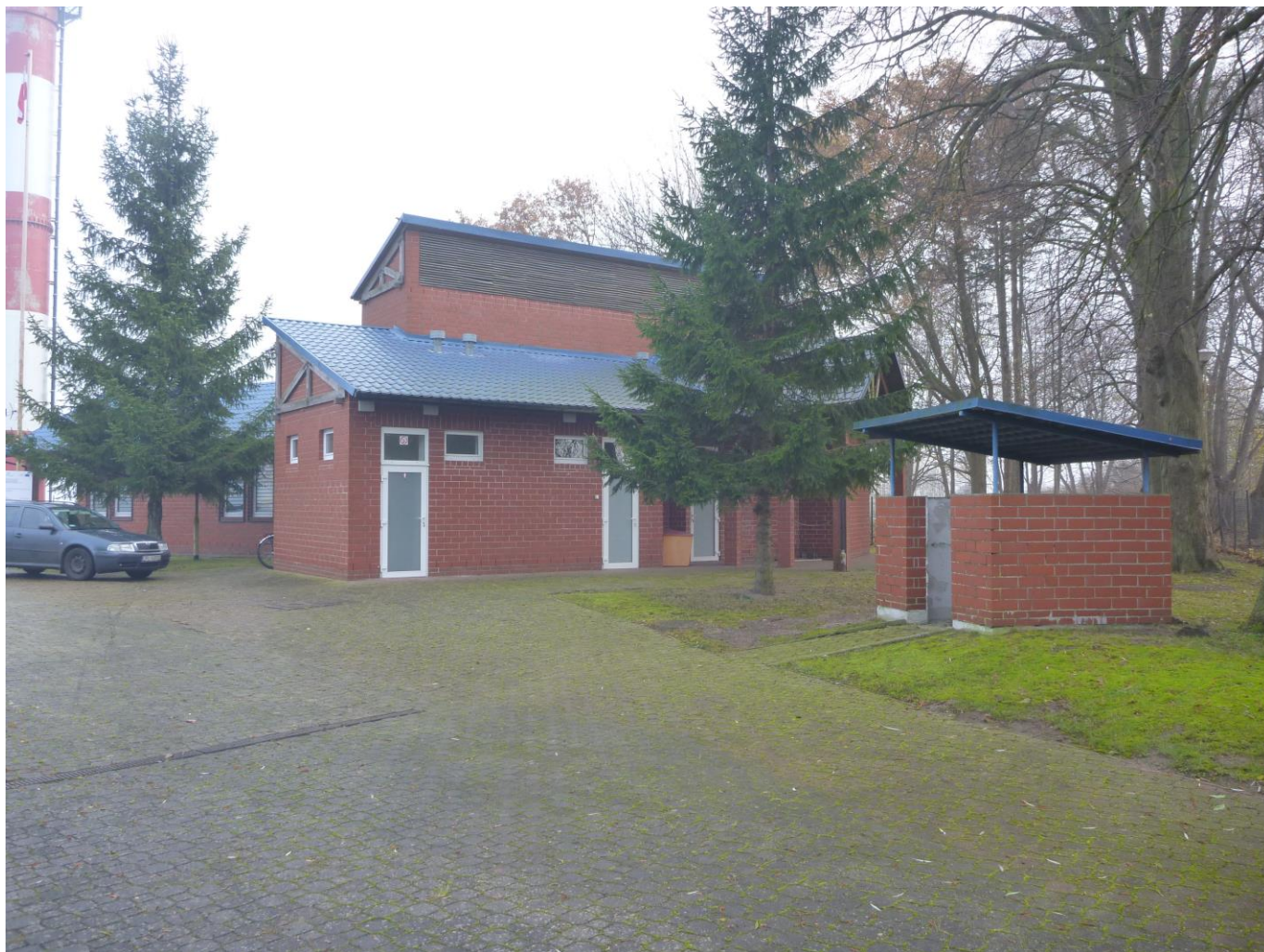
Fot. 05 Widok od strony zachodnio-południowej
