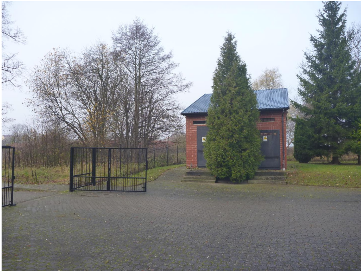
Fot. 16 Trafostacja – widok z przodu
