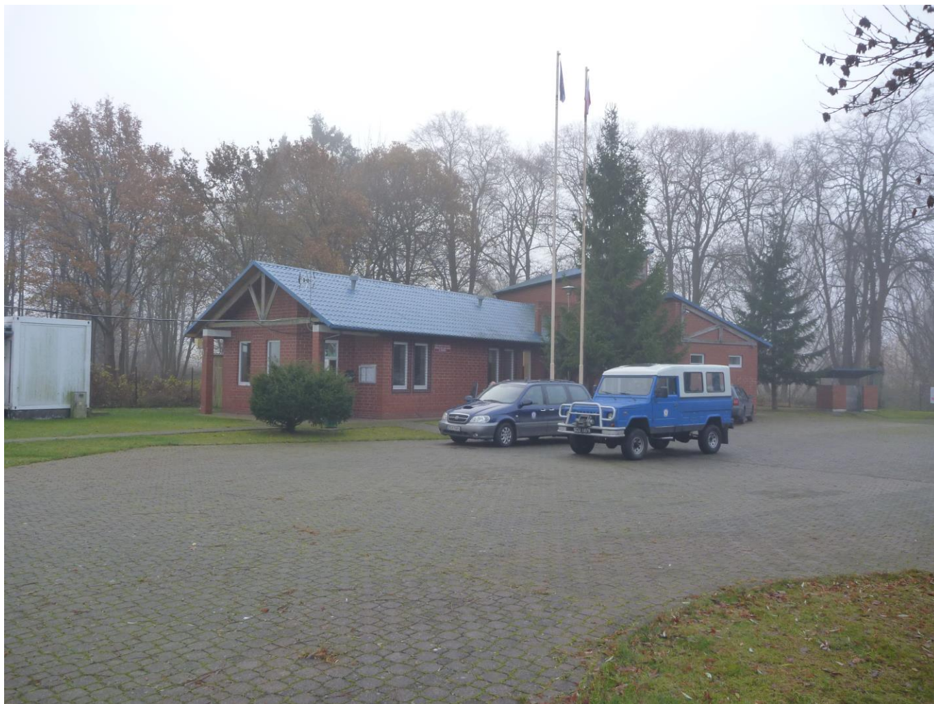
Fot. 03 Widok ogólny budynku byłego Morskiego Przejścia Granicznego od strony północno-zachodniej
