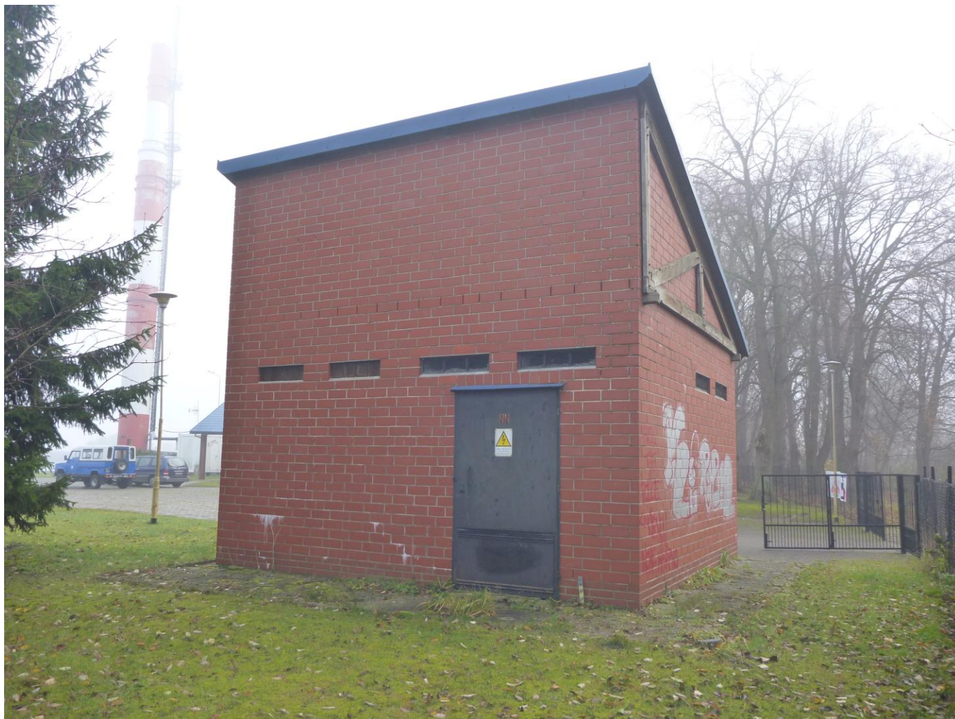
Fot. 17 Trafostacja – widok z tyłu
