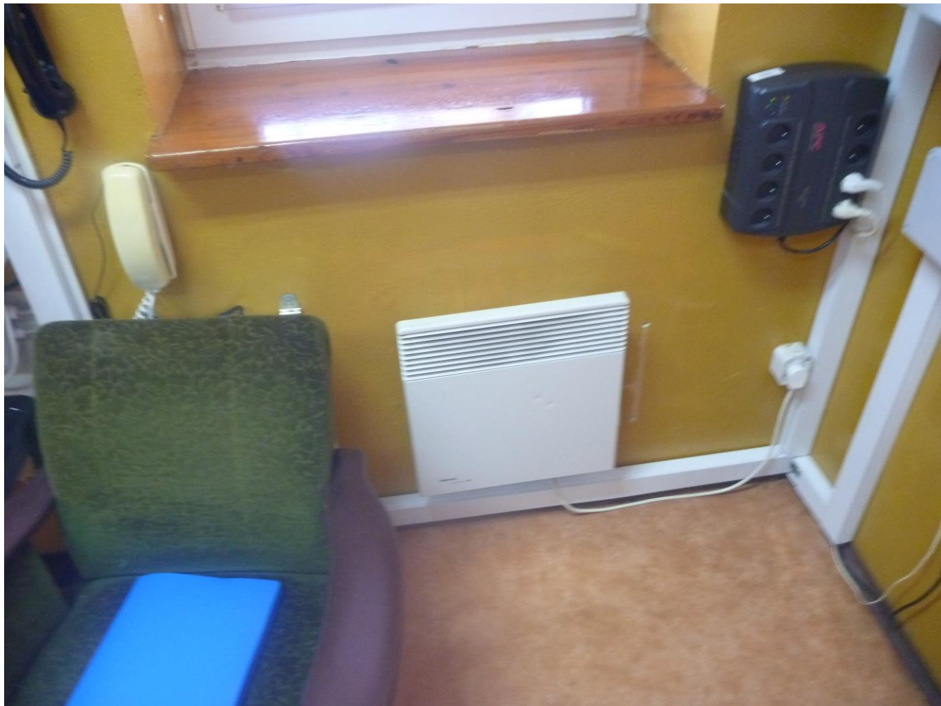
Fot. 30 Budynek byłego MPG. Pomieszczenia bosmanatu – aktualne ogrzewanie
