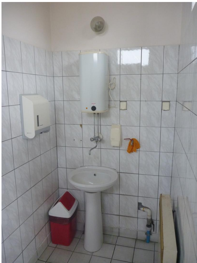
Fot. 43 Budynek byłego MPG. WC
