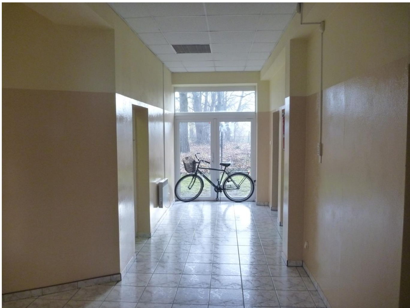
Fot. 21 Budynek byłego MPG. Korytarz główny
