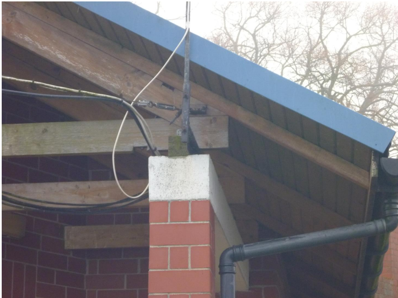
Fot. 12 Wieżba dachowa
