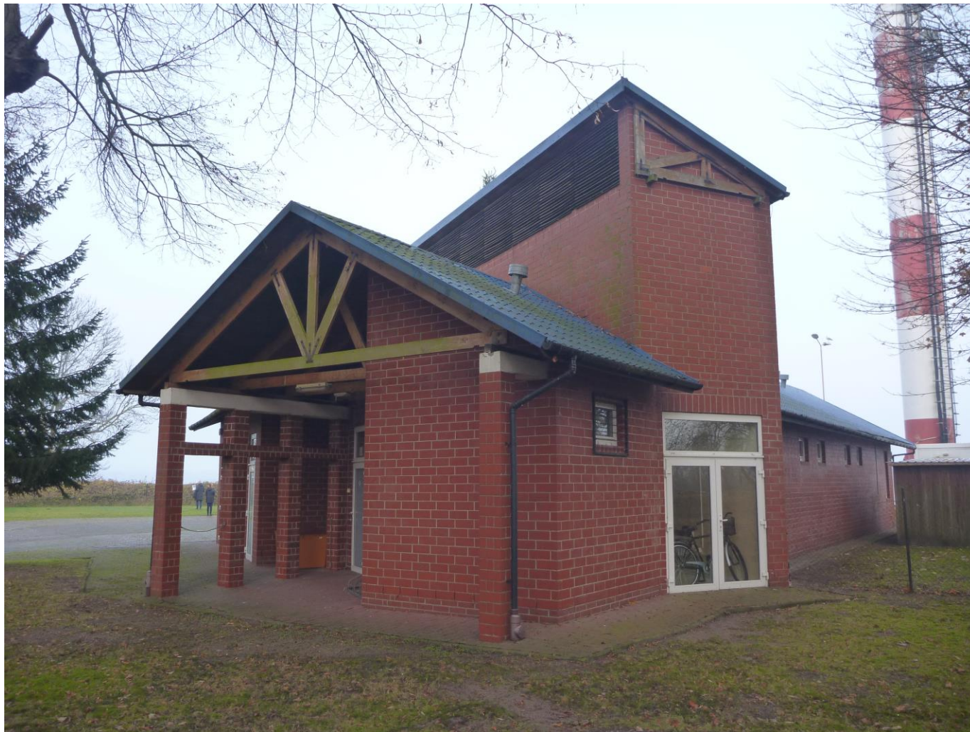
Fot. 04 Widok ogólny budynku byłego Morskiego Przejścia Granicznego – od strony południowej (widoczny układ dźwigarów dachowych)
