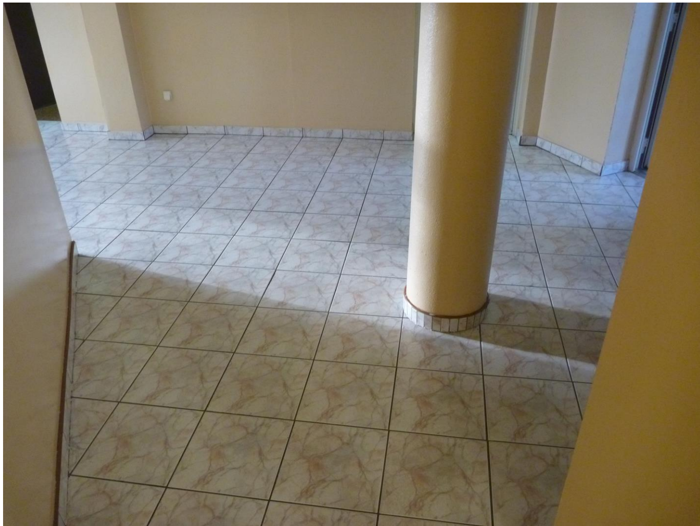
Fot. 22 Budynek byłego MPG. Korytarz główny
