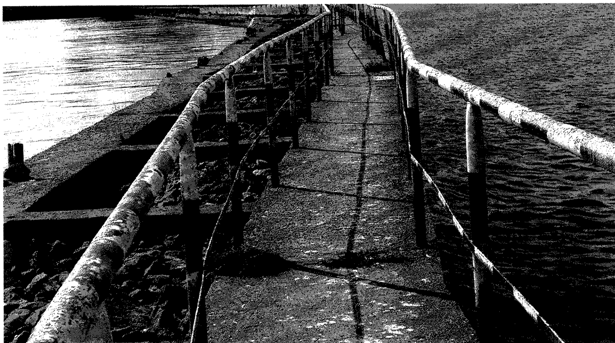
Rys. Widok bariery ochronnej
