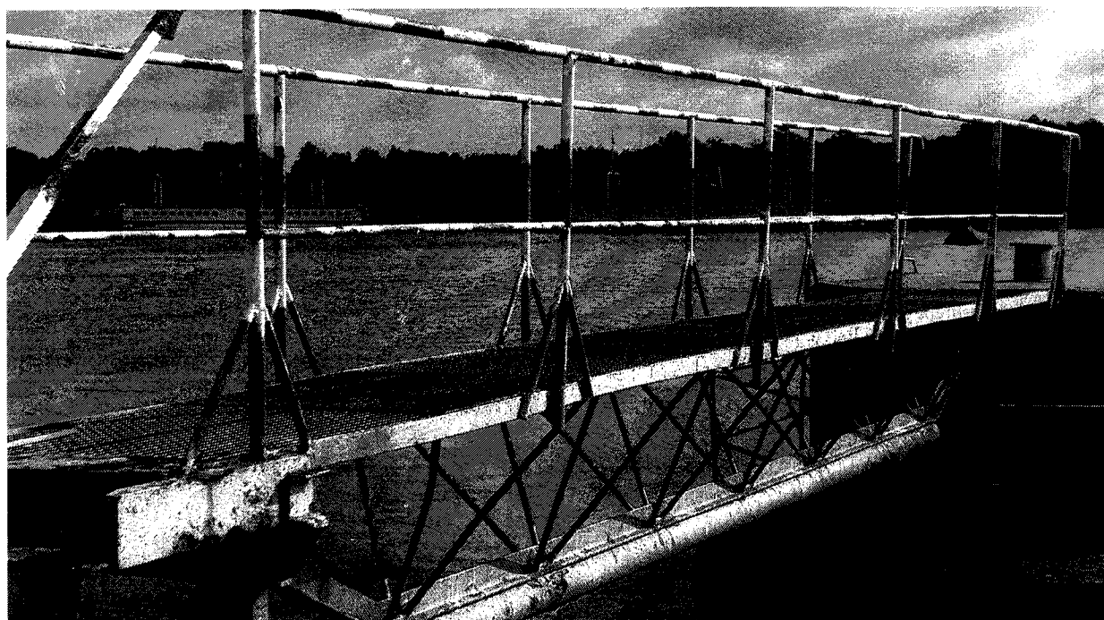
Rys. Widok kratownicy z barierą ochronną
