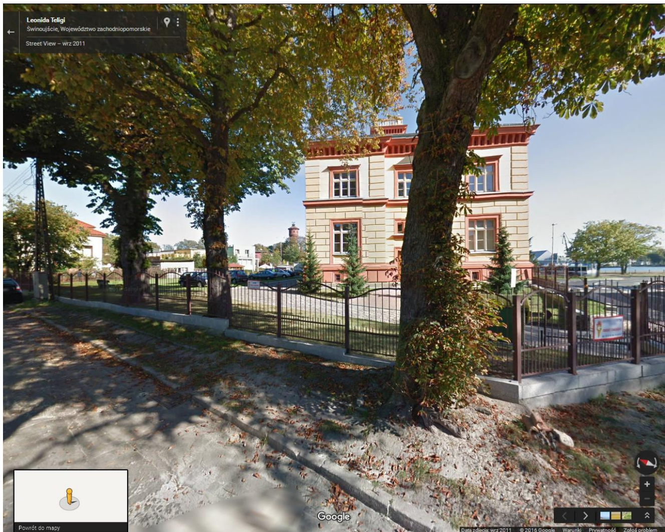
Fot. 06 Widok elewacji południowej – istniejąca droga wjazdowa na parking
