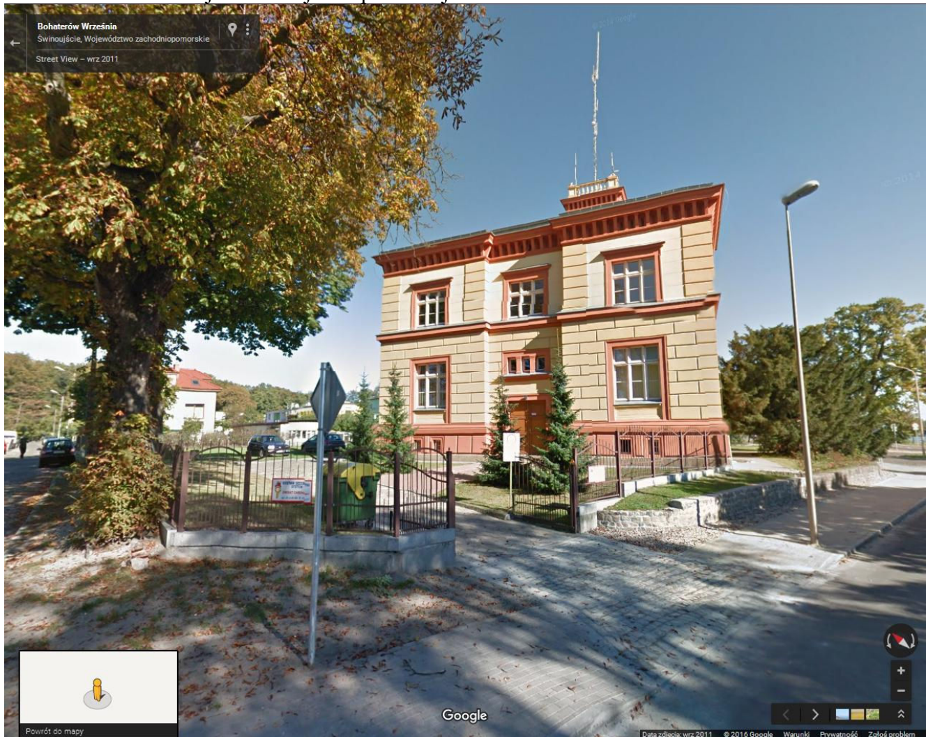
Fot. 05 Widok elewacji południowej – istniejąca droga wjazdowa na parking
