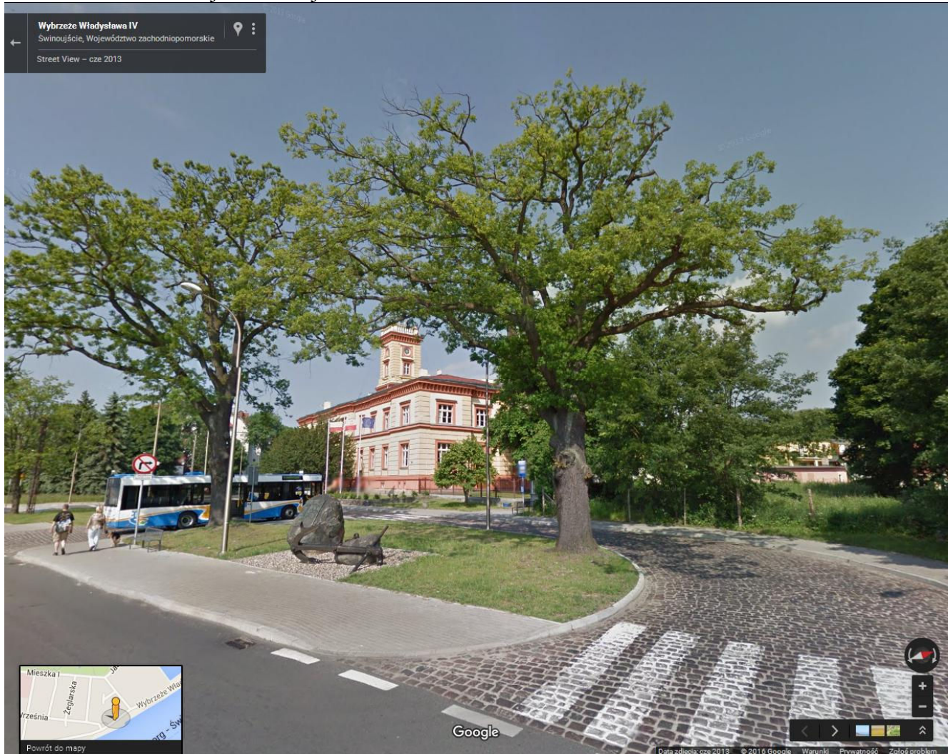
Fot. 03 Widok elewacji frontowej
