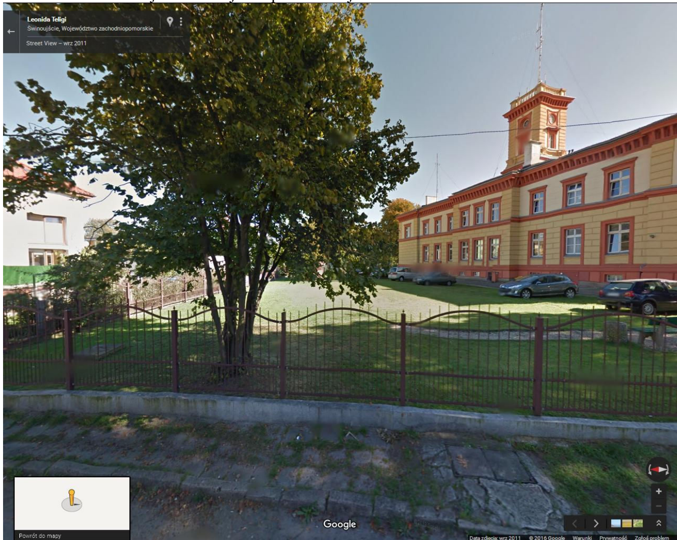
Fot. 08 Widok elewacji zachodniej – istniejący parking do rozbudowy
