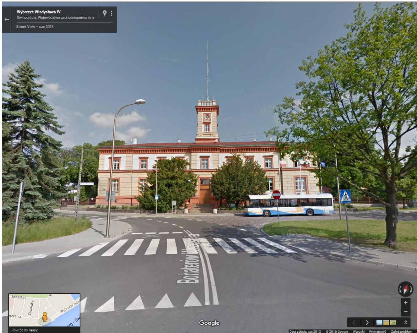
Fot. 02 Widok elewacji frontowej
