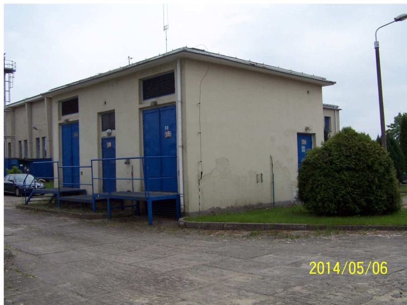
Fot. 01 Widok ogólny
