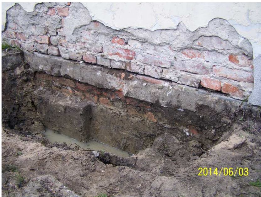
Fot . 10 Ściana południowa – Odkrywka fundamentu
