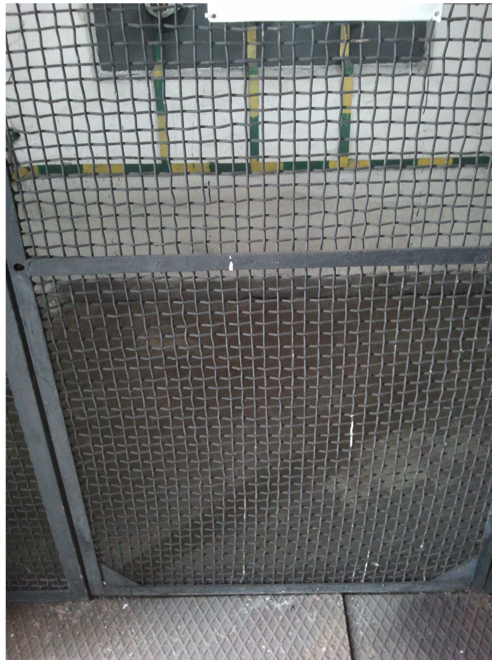
Fot . 46 Pomieszczenie Nr 1 SN – widok na posadzkę i kanały kablowe
