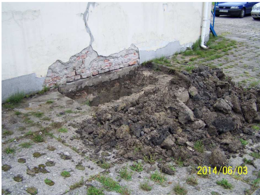
Fot . 09 Ściana południowa – Odkrywka fundamentu
