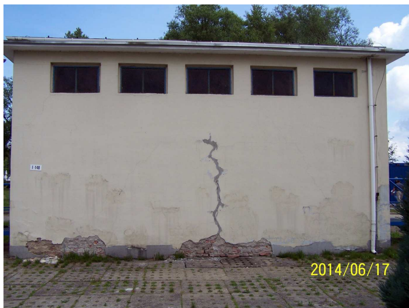
Fot. 06 Elewacja południowa
