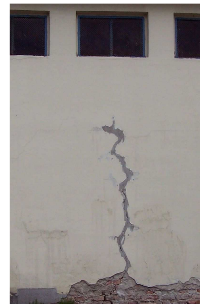
Fot. 07 Rysa w ścianie południowej – Porównanie stanu z 2006r. i obecnego 2014r.
