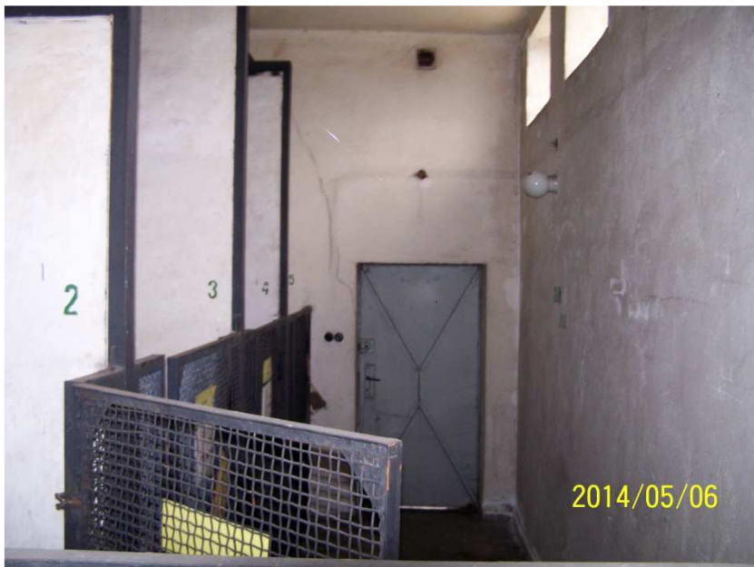
Fot . 37 Pomieszczenie Nr 1 SN – Widok ogólny
