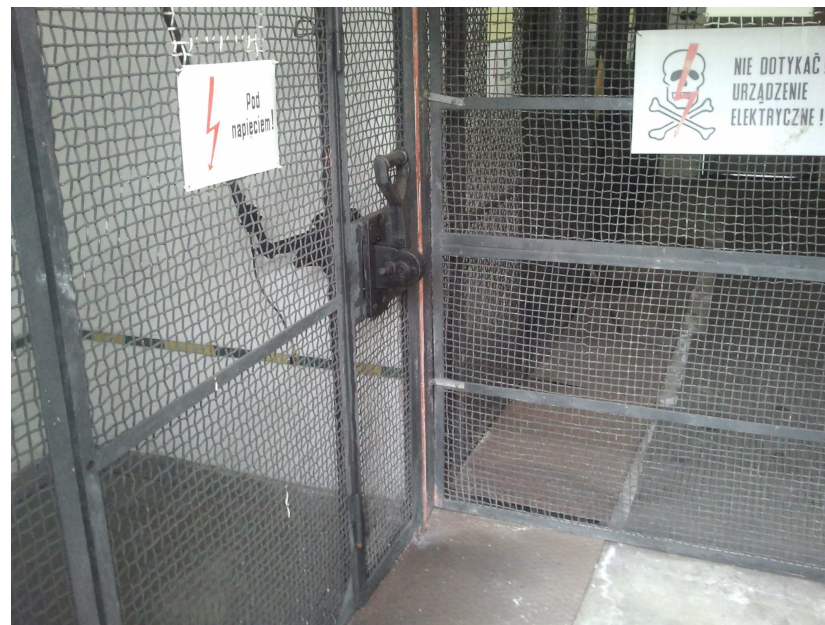
Fot . 43 Pomieszczenie Nr 1 SN – widok na boksy
