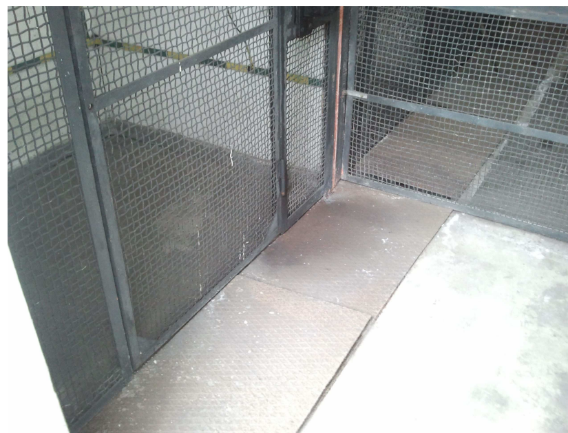
Fot . 44 Pomieszczenie Nr 1 SN – widok na posadzkę i kanały kablowe
