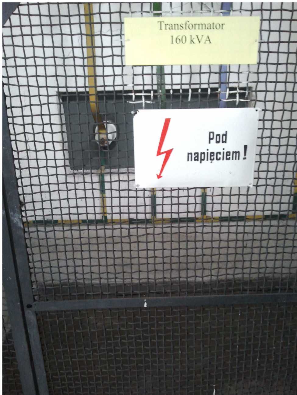
Fot . 45 Pomieszczenie Nr 1 SN – widok na boks
