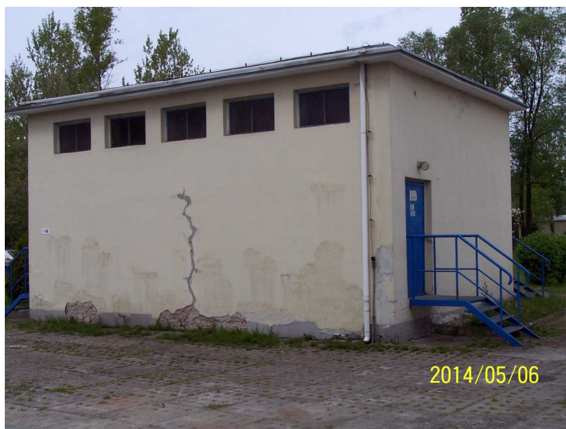
Fot. 02 Widok ogólny
