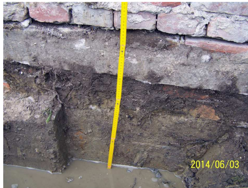
Fot . 11 Ściana południowa – Odkrywka fundamentu
