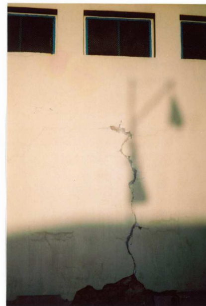
Fot. 07 Rysa w ścianie południowej – Porównanie stanu z 2006r. i obecnego 2014r.
