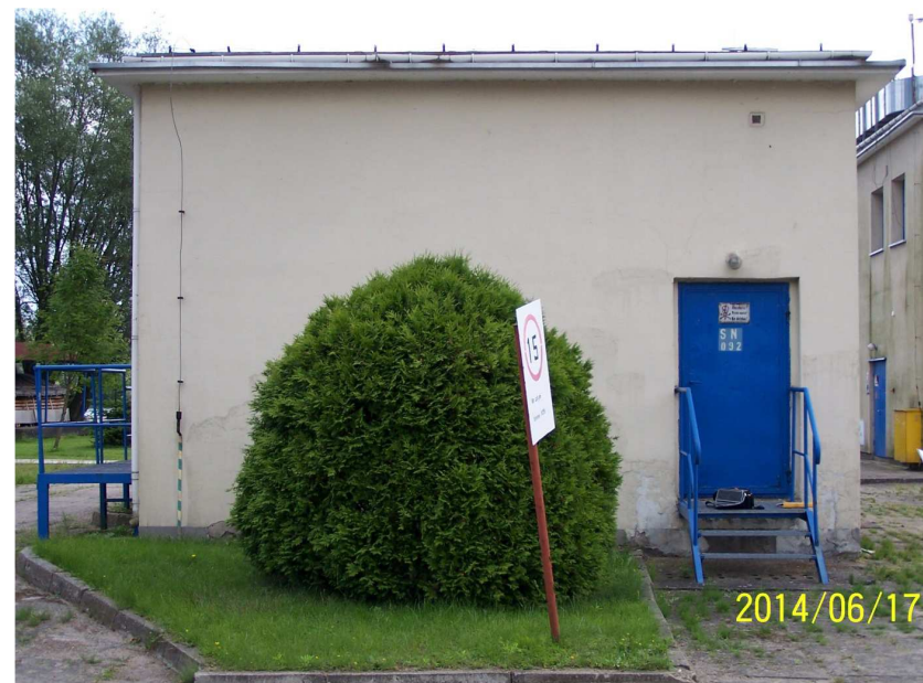
Fot. 03 Elewacja zachodnia
