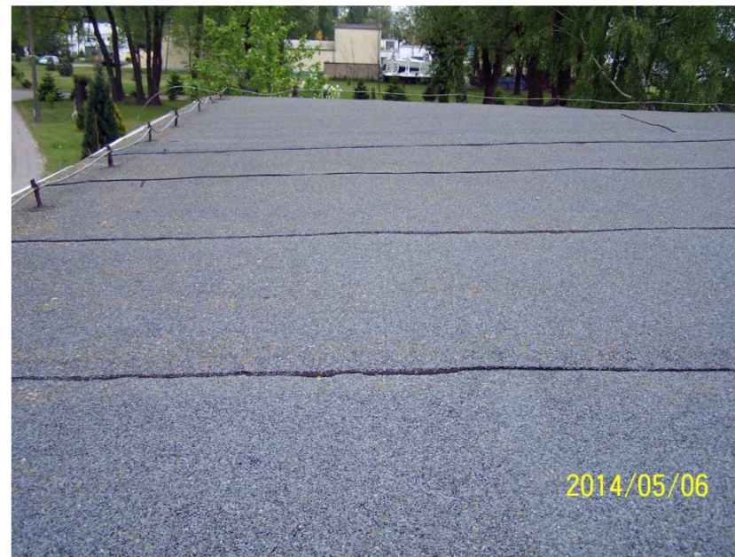
Fot . 31 Dach – Pokrycie z papy termozgrzewalnej
