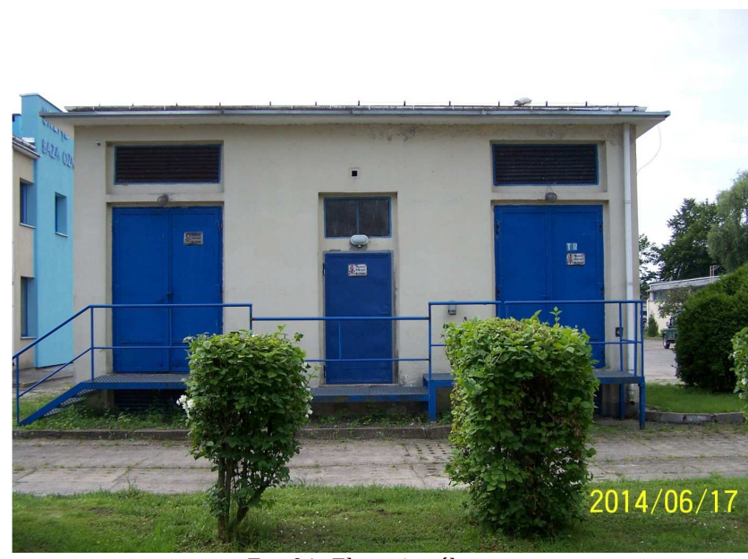
Fot. 04 Elewacja północna
