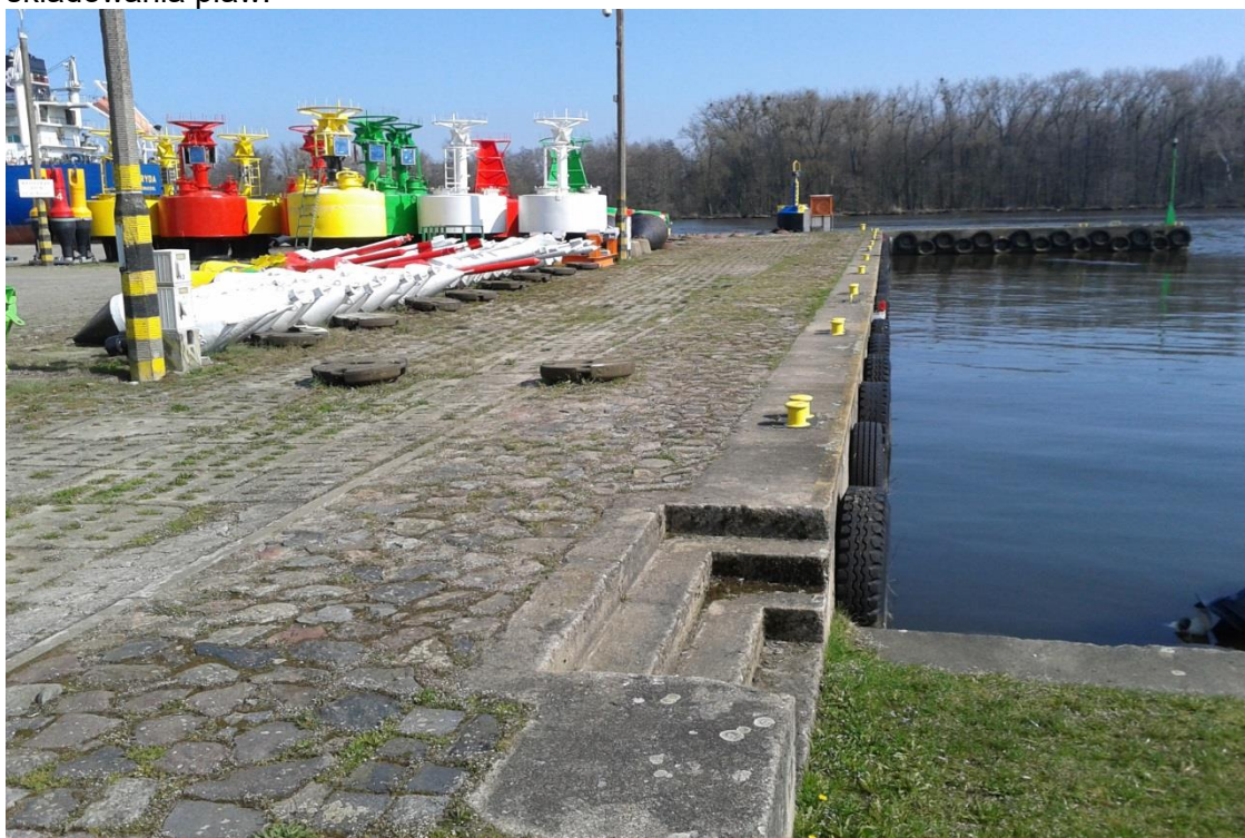
Ryc. 4. Baza Oznakowania Nawigacyjnego w Szczecinie przy torze wodnym Świnoujście-Szczecin. Widok na fragment basenu gospodarczego i plac składowania pław.
