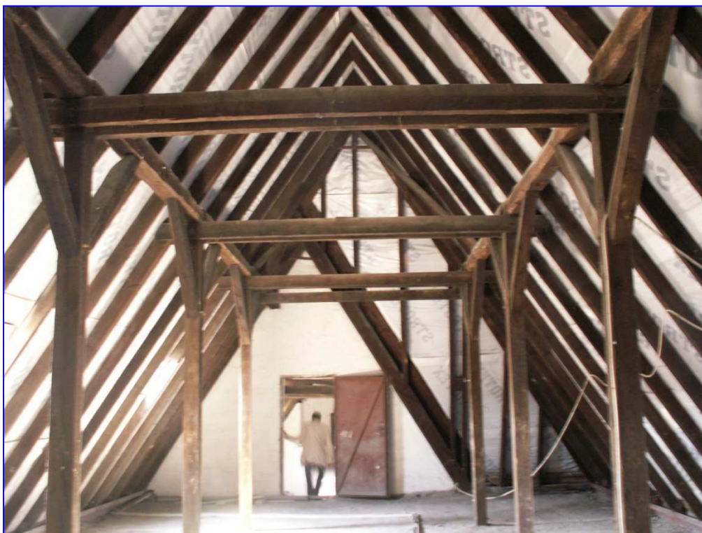
Konstrukcja dachu w obrębie wieży.
