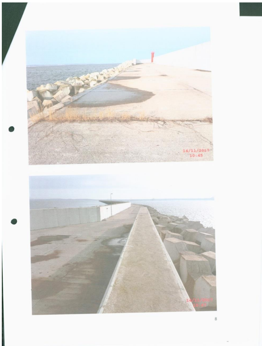
Zdjęcie nr 6. Porosty na dylatacjach na falochronie Wschodnim.
