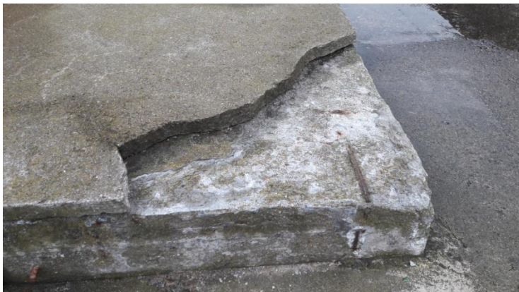
Zdjęcie nr 1. Uszkodzenie na podstawie znaku nawigacyjnego nr1
