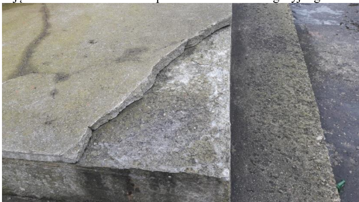
Zdjęcie nr 1. Uszkodzenie na podstawie znaku nawigacyjnego nr1
