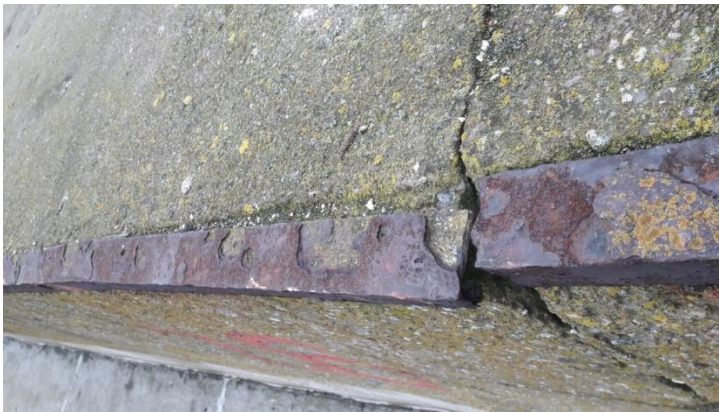
Zdjęcie nr 4. Uszkodzony kątownik na parapecie
