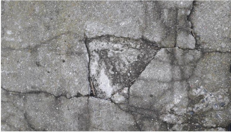
Zdjęcie nr 3. Uszkodzenie nawierzchni płyty falochronu
