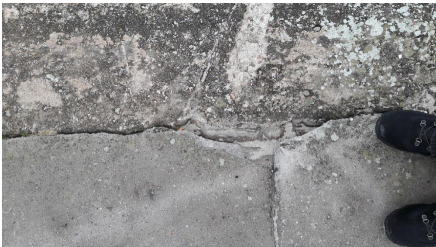
Zdjęcie nr 7. Połączenie płyty nawierzchni z oczepem
