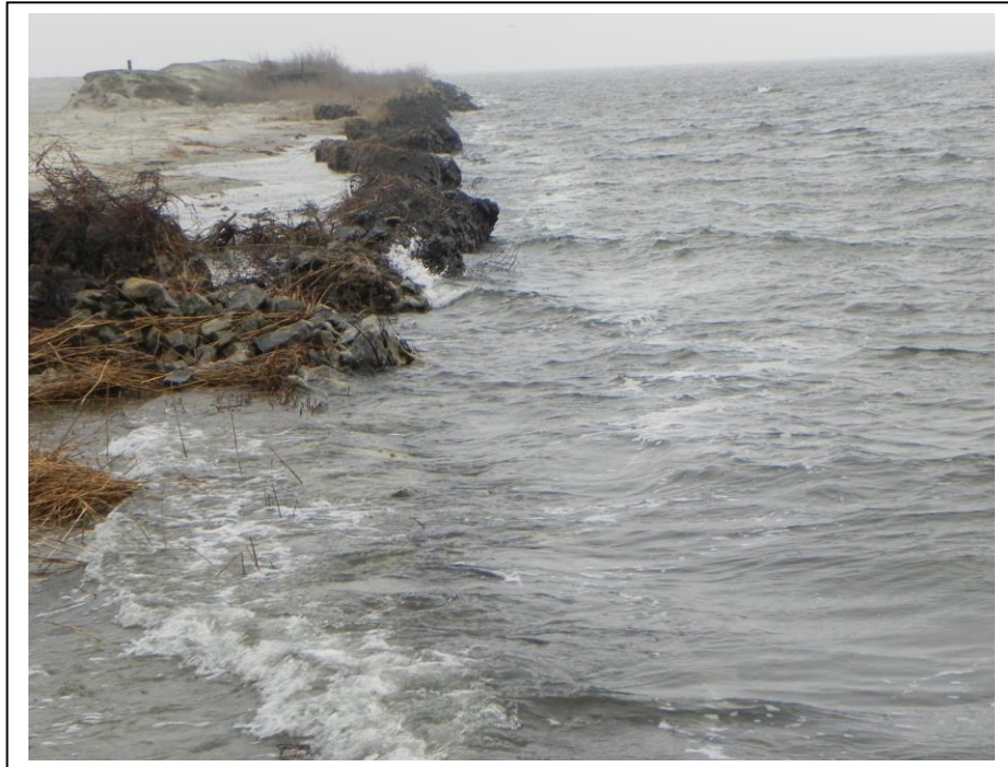
Fot. 4 I typ zniszczenia
