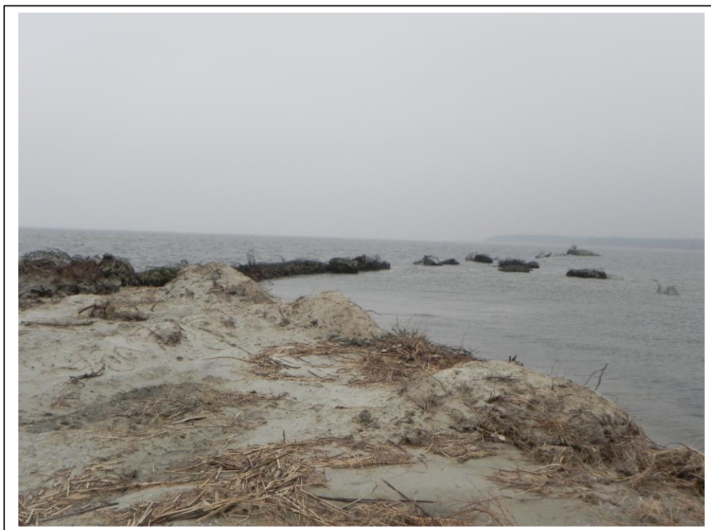
Fot. 1 III oraz IV typ zniszczenia
