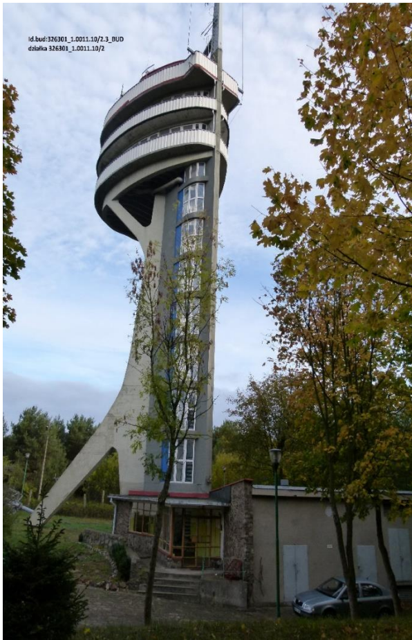
Fot.1. Teren przed rozpoczęciem inwestycji
