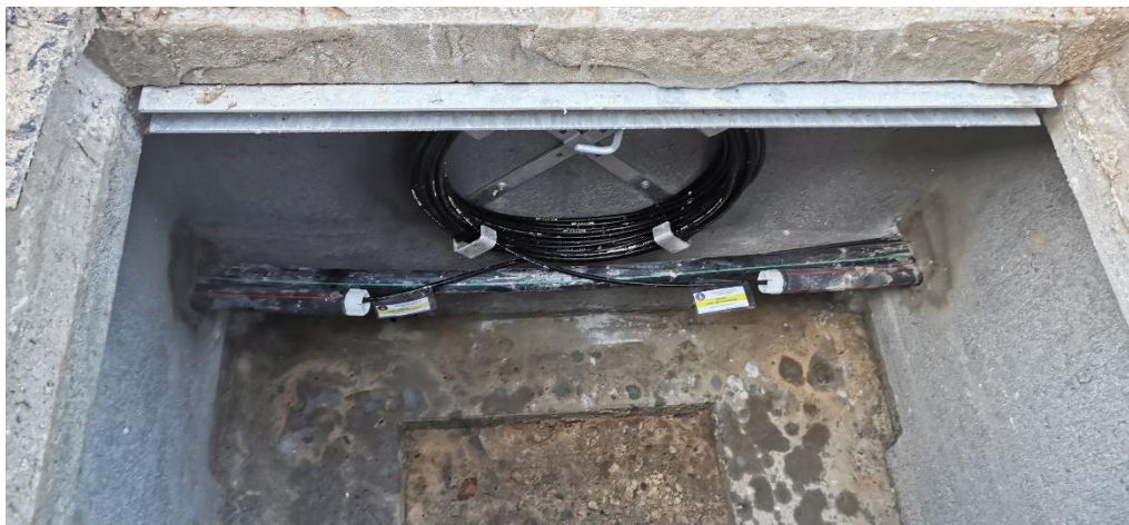
Fot. 1 Budowa przyłącza światłowodowego w Międzyzdrojach (studnia kablowa)
