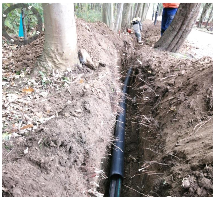
Fot. 2 Budowa przyłącza światłowodowego w Niechorzu
