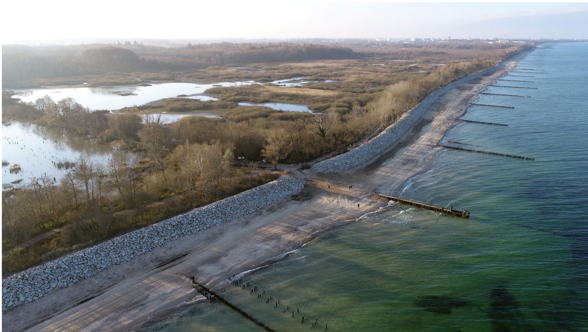
Opaska brzegowa w Ekoparku wschodnim w Kołobrzegu.
