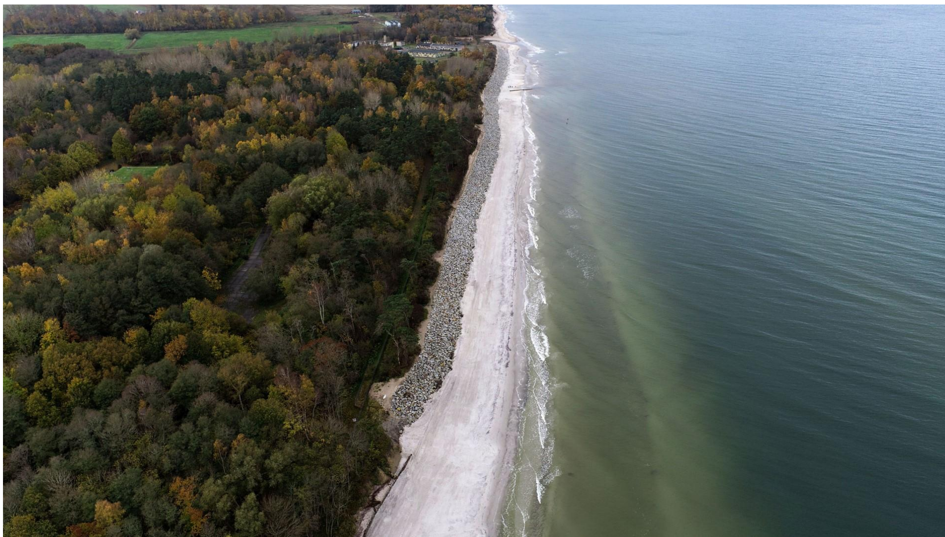
Opaska brzegowa i sztuczne zasilenie brzegu morskiego w Pleśnej.
