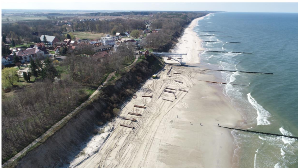
fot. 3 – odcinek Rewal - Trzęsacz po budowie ostróg sztucznym zasilaniu
