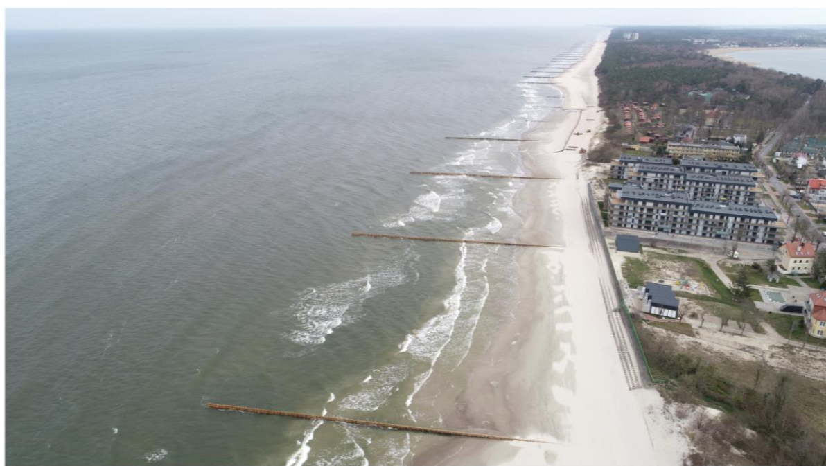
fot. 5 – Dziwnów (rozszerzenie projektu) – wymiana zniszczonych ostróg „T” i budowa nowych – po zakończeniu prac
