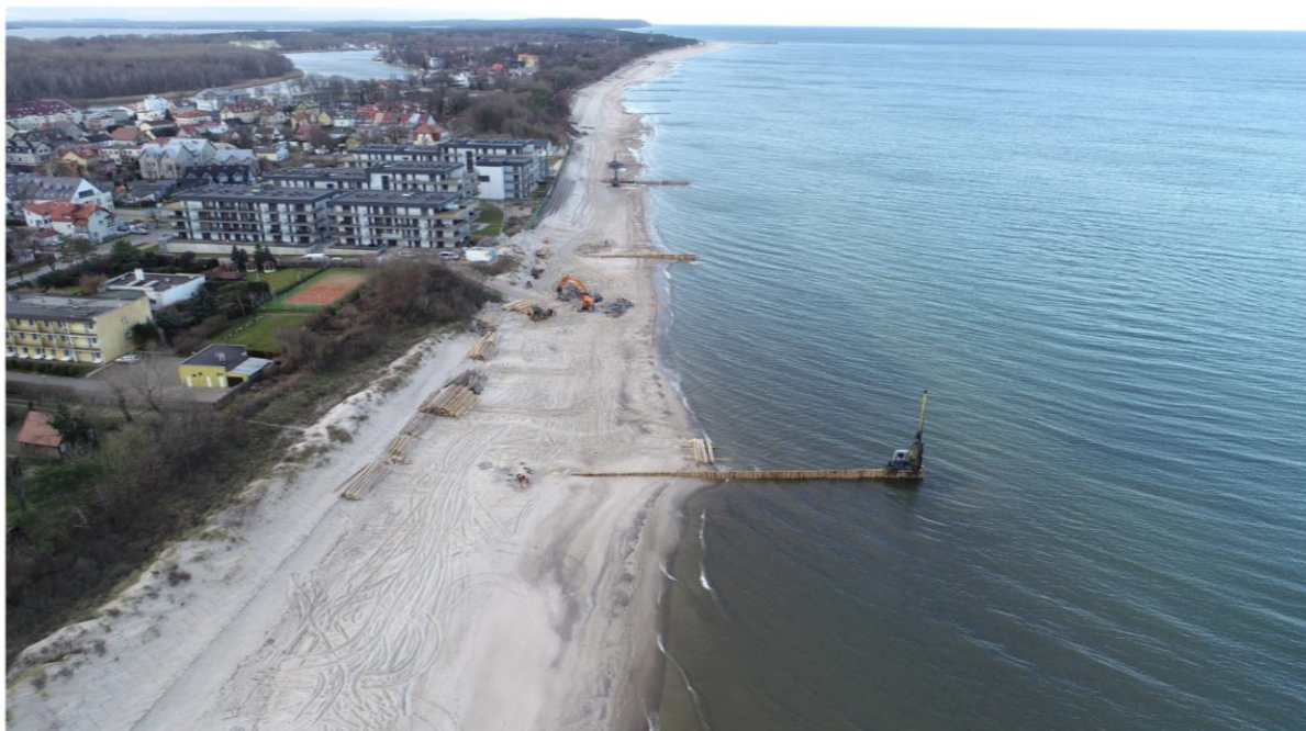
fot. 4 – Dziwnów (rozszerzenie projektu) – wymiana zniszczonych ostróg „T” i budowa nowych
