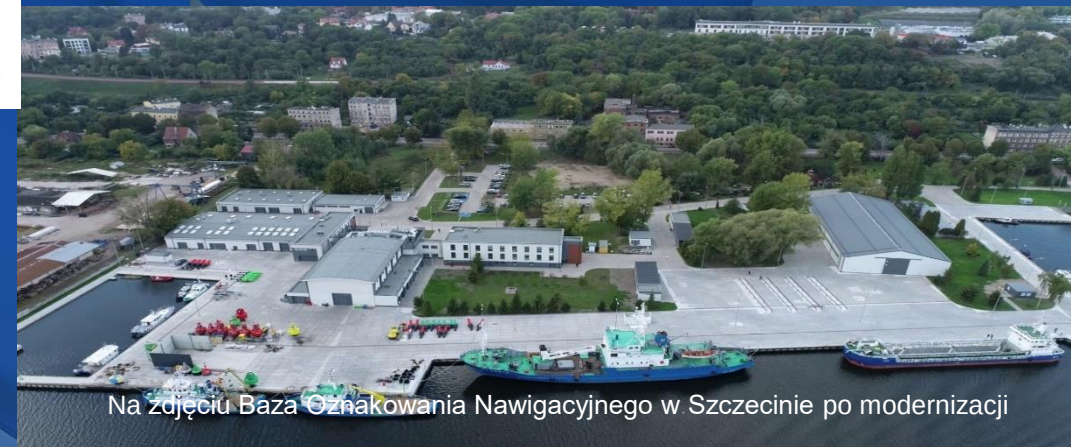
Na zdjęciu Baza Oznakowania Nawigacyjnego w Szczecinie po modernizacji
